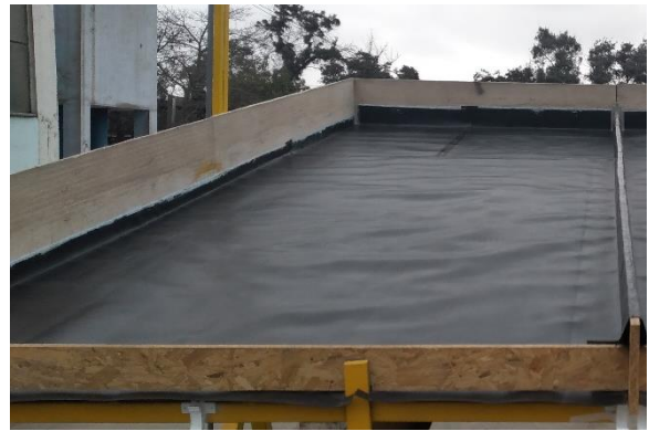
Fig. 10 Waterproof layer, 1mm HDPE geomembrane.
